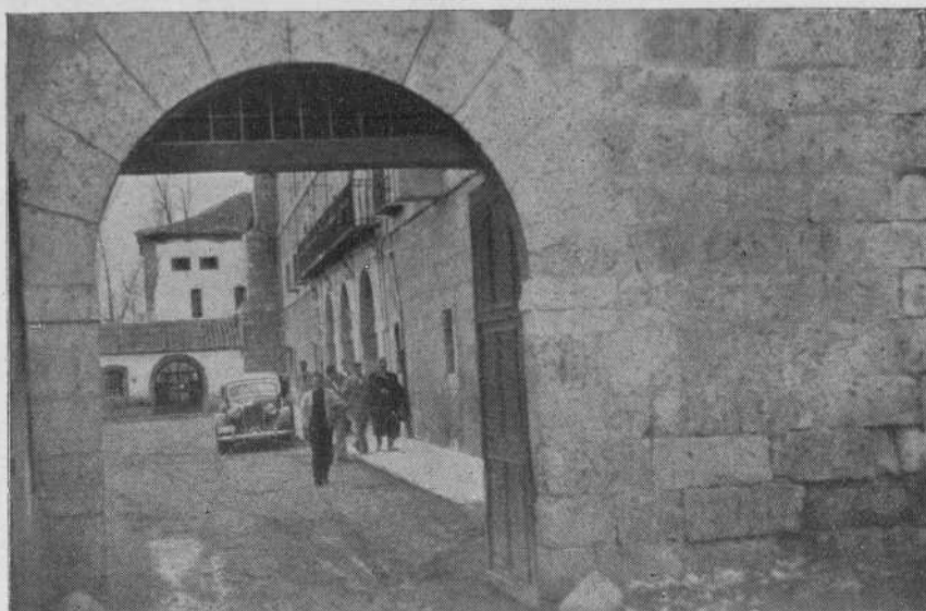
Fot. 1.—«RETUERTA». Entrada al núcleo de edificaciones
