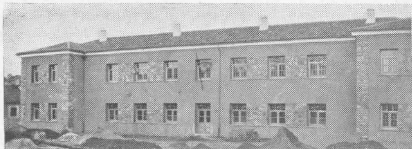
Grupo escolar, modelo perfectísimo de esta clase de edificios destinados a la enseñanza. Está sólidamente construido con todas las exigencias pedagógicas modernas.
