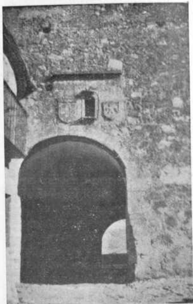
Puerta de la Villa tomada desde el interior.
