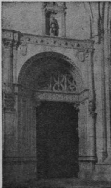
PUERTA EN DESVIAJE QUE DA ENTRADA AL CLAUSTRO DE LA CATEDRAL
