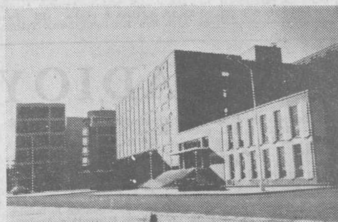
Aspecto que ofrece, entre sol y sombra, la edificación gemela de la Escuela de Ingeniería Técnica de Obras Públicas. (Foto FEDE)
