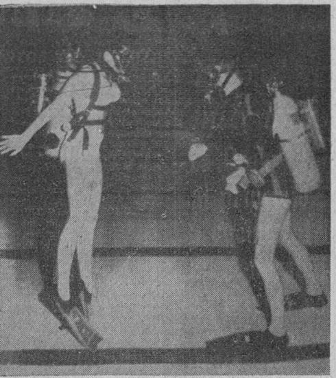
Un sistema de comunicación bajo el agua que utiliza solamente el oído humano como receptor, ha sido ensayado recientemente en Nueva York. El aparato se llama «Watercom» y permitirá a un buceador hablar con las personas situadas dentro de un radio de unos 100 metros. El sonido de la voz es amplificado a través del agua y puede ser oído sin ayuda de especial equipo receptor. En la fotografía vemos dos buceadores realizando una demostración del aparato. — (Foto Fiel)
