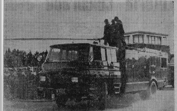
Modernísimo coche adquirido por el Ayuntamiento para el Parque de bomberos. El pequeño cañón de que está dotado y que figura en la parte superior del vehículo permite lanzar espuma y polvo con gran fuerza y en grandes cantidades contra las llamas. — (Foto FEDE)
