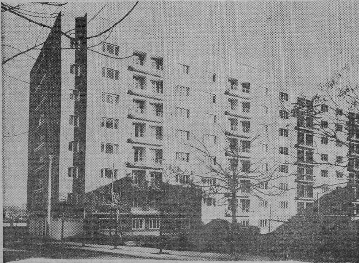
El problema de la vivienda en España se funde en el gran caos de los arrendamientos urbanos.
