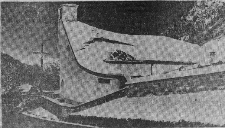
En término de Langen, en el Arberg alemán, se ha construido esta iglesia especialmente diseñada para evitar los peligros de los aludes de hielo y nieve en el invierno. Se trata de una especie de «bunker» y cuya parte que da a la montaña tiene forma de tres esquinas, de modo que en caso de alud lo corte y lo haga rebasar el edificio. La entrada está bajo la torre. Si el modelo resulta eficaz se construirán otras iglesias como esta en Suiza y Austria. — (Foto FIEL)
