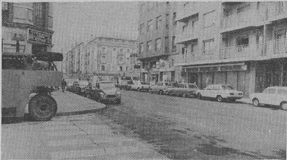
Obras importantes de mejora de la calzada está llevando a cabo estos días el Ayuntamiento en la calle General Mola, como muestra la fotografía de «Fede».
