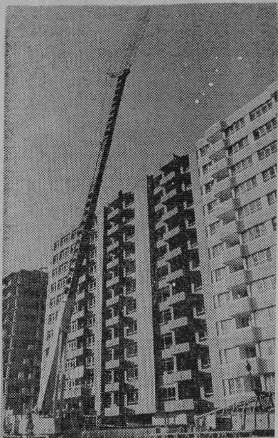
Una grúa portátil de 76 metros de altura instalada en unas obras de la Avda. General Yagüe, que obligó a cortar la circulación durante un buen espacio de tiempo. (Foto "Fede")
