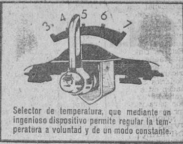
Selector de temperatura, que mediante un ingenioso dispositivo permite regular la temperatura a voluntad y de un modo constante.
