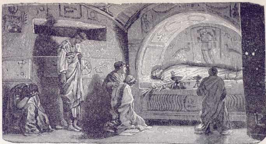
EN LAS CATACUMBAS.
