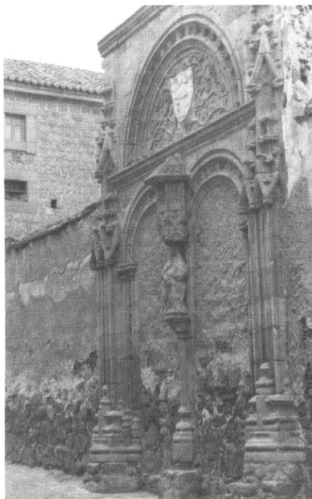
Portada de la Iglesia y Hospital de Santa Escolástica.
