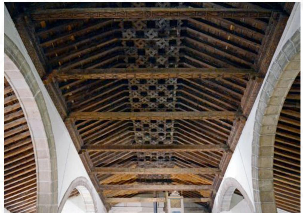
armadura de la nave central y forjados inclinados de las laterales
