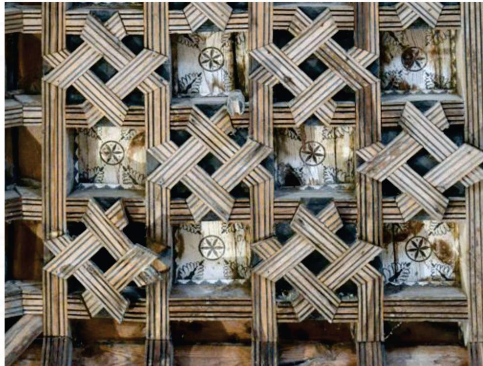
lacería ejecutada mediante la técnica *apeinazada*. Armadura de cubierta de la iglesia de Canales (Ávila)
