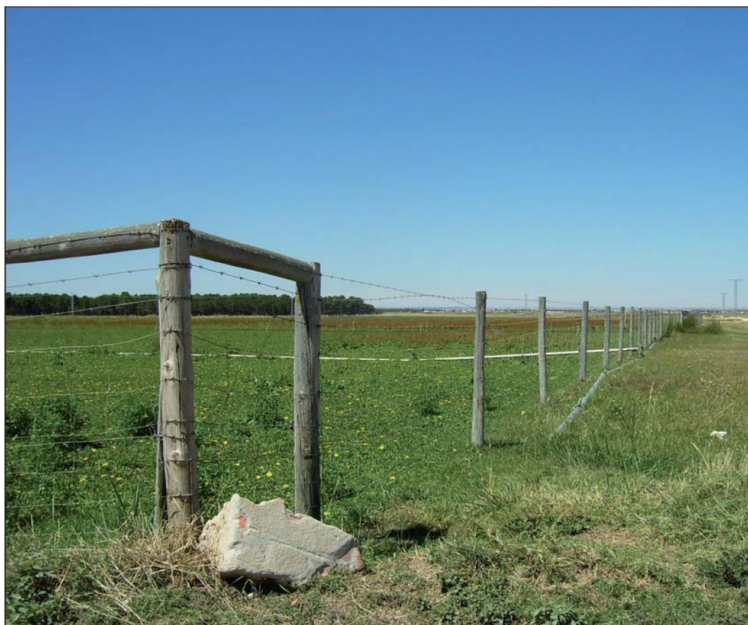
Figura 16: Cerca con cerramiento combinado y postes de madera tratada.
