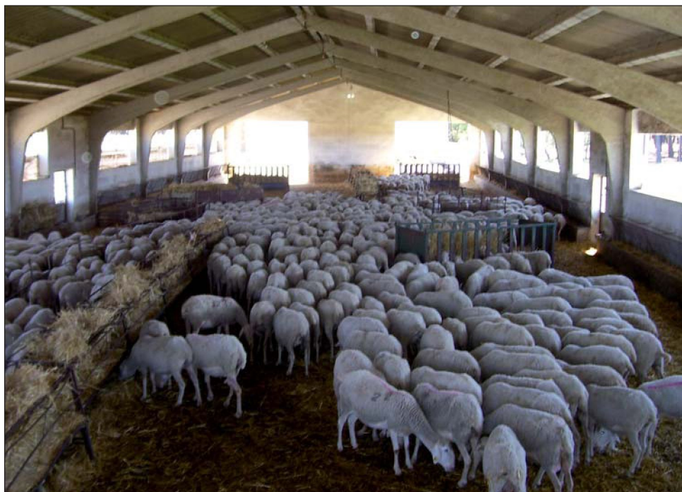
Figura 3: Nave con estructura de hormigón y distribución diáfana.
