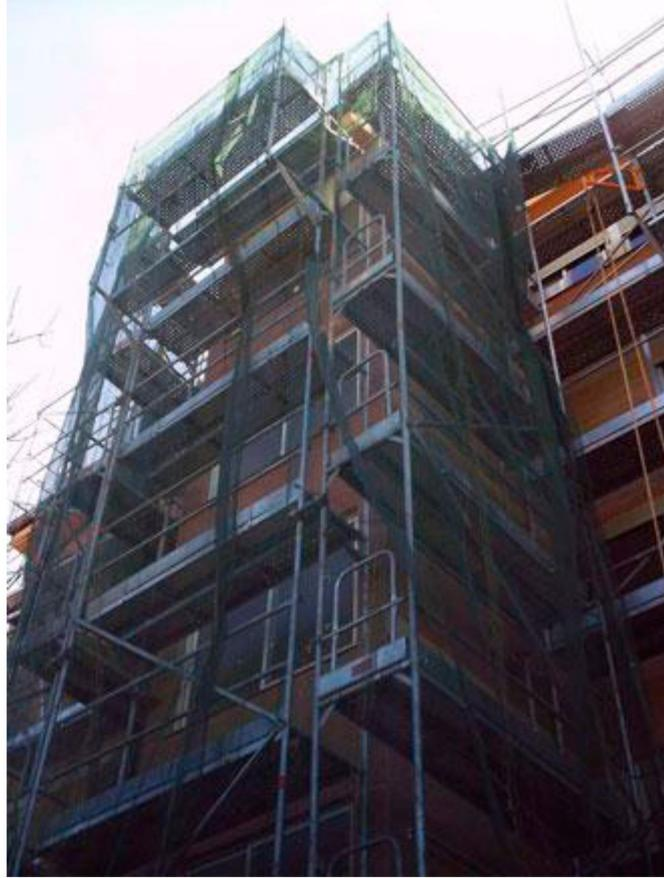
*Figura 6.14- Foto de un andamio tubular de fachada*
