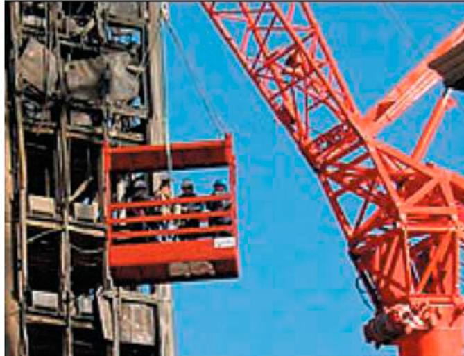
Figura 6.28- Foto de una cesta suspendida mediante grúa para elevación de personas.
