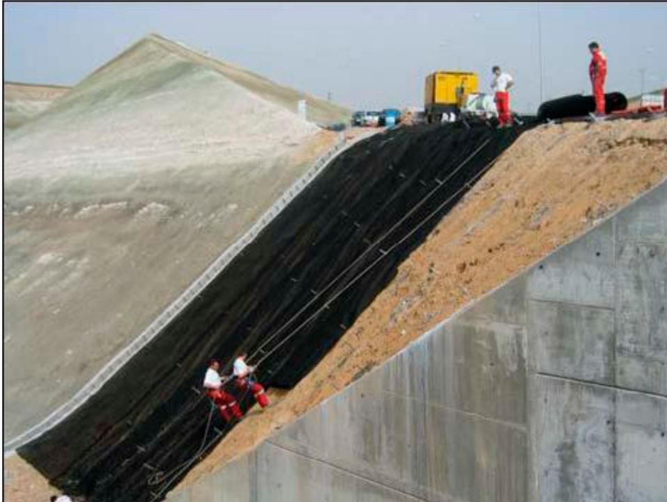
*Figura 6.29- Foto de un trabajo de posicionamiento mediante cuerdas.*
