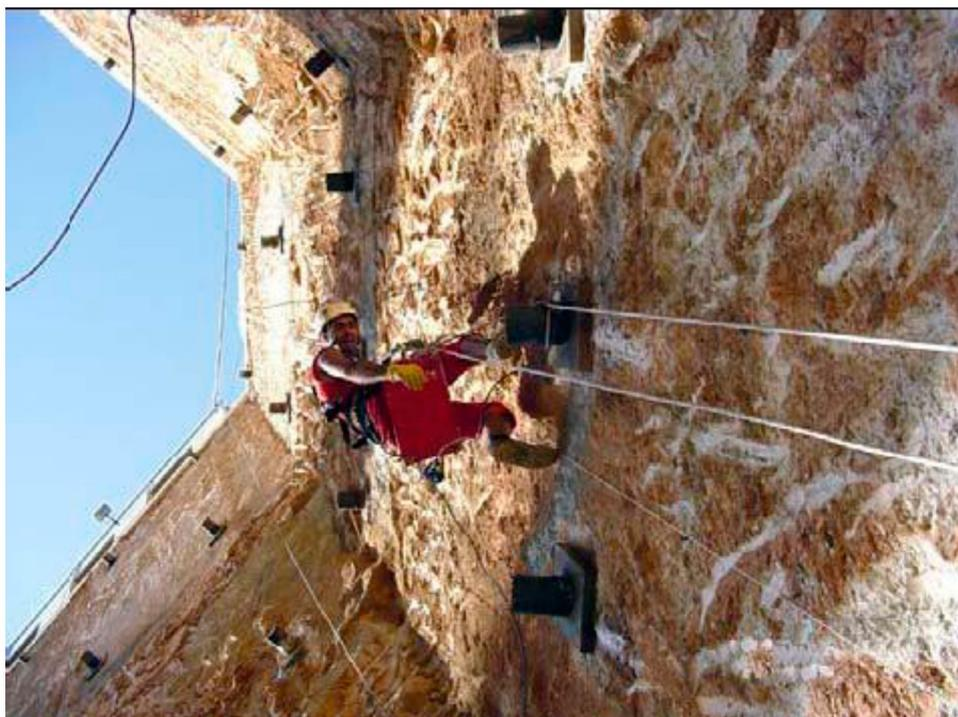
*Figura 6.30- Foto de un trabajo de posicionamiento acceso mediante cuerdas, donde puede observarse la silla con el cinturón de seguridad.*
