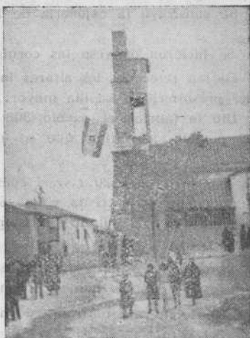
Estado de las Obras el día de la inauguración del reloj.
