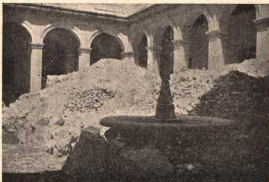
en las cañerías de salidas de aguas que habían producido profundas filtraciones y humedades, se levantó el piso del patio, encontrándose entonces.
