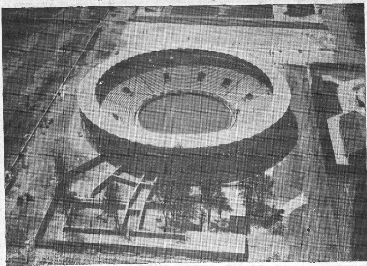
Nueva Plaza de Toros de Burgos Emp. Constructora: Agosa
