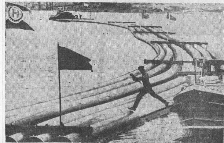
Curioso transporte por las aguas del Elba a su paso por Hamburgo (Alemania). Un remolcador arrastra seis tubos de 300 metros de largo y 60 centímetros de diámetro hacia Nordenham, en el río Weser, donde serán utilizados para el desagüe de una gran fábrica que está construyendo. — (Foto FIEL).
