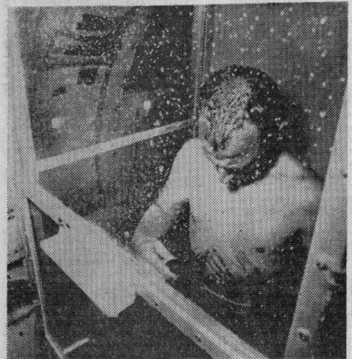
Las pruebas efectuadas con una ducha instalada a bordo de un avión KC-135 de la fuerza aérea de EE. UU., en un compartimento donde se simuló la ausencia de gravedad, demostraron que es posible que los cosmonautas se duchen en pleno vuelo espacial. (Foto FUNIC)
