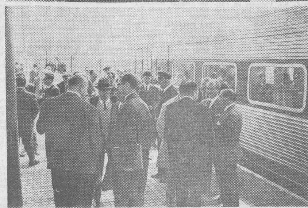
Al apearse del "Talgo" los ingenieros del Ministerio de Obras Públicas y de la RENFE son cumplimentados por el inspector jefe principal de movimiento señor Fernández-Abascal. En el grabado inferior, aspecto que presentaba el andén del "Directo", ocupado por los técnicos que hicieron el viaje de pruebas. — (Fotos FEDE).
