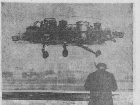
Bremen (Alemania). — En la fotografía aparece el «VAK 191» avión de despegue vertical que realiza las primeras pruebas en el aeropuerto de esta ciudad. Se cree que el avión está ya funcionando en 1969. — (Telefoto UPI-CIFRA)
