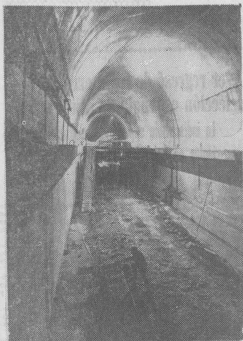
Wuppertal. — Esta bóveda representa quizás la obra más interesante de Europa. En Wuppertal se está construyendo el primer túnel de dos pisos de Europa que, en una longitud de 855 metros, atraviesa un monte de tierra arenisca. La foto muestra las dos trazas en el túnel de trece metros de altura, destinadas cada una para la circulación en una sola dirección. La ventilación será proporcionada ampliamente por el remolino producido por la corriente de vehículos. — (Foto DAD)
