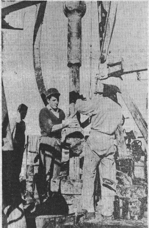
Durante nuestra visita al campo se produjo la necesidad de empalmar nuevo varillaje para proseguir la tarea perforadora en el interior del pozo. He aquí un momento del trabajo de ajuste que es preciso realizar para llevar a efecto los correspondientes empalmes. — (Foto "Fede")
