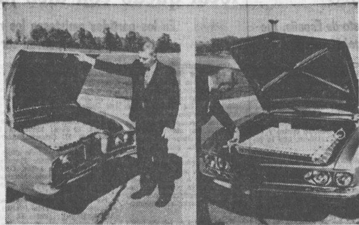
Automóvil eléctrico construido por la General Motors. Está alimentado por baterías de plata-zinc (Foto CIFRA)
