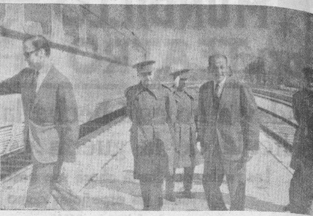
El director general de Ferrocarriles, acompañado del alcalde de Aranda, don Luis Mateos Martín y de los jefes de la Academia de Ingenieros de Burgos durante la visita que hicieron a las obras del ferrocarril Madrid - Burgos. — (Foto Díaz).
