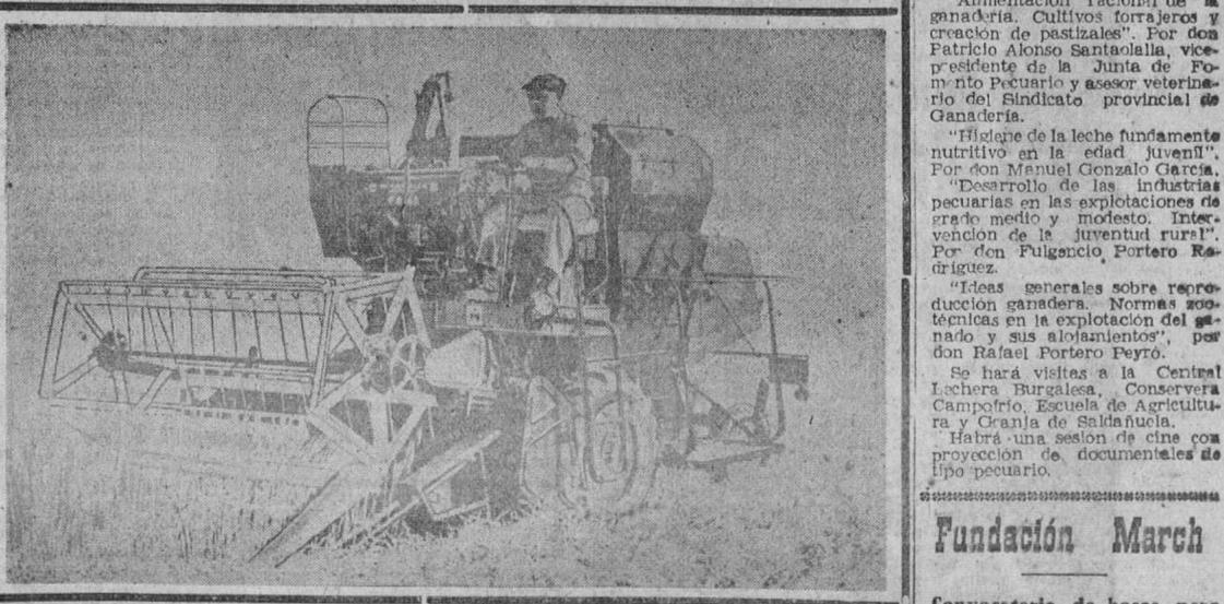
Es una cosechadora autopropulsada «McCORMICK-INTERNATIONAL» Con motor Diesel «INTERNATIONAL» de 35 HP. y 4 cilindros verticales Ancho de corte 2'15 y 2,62 metros Velocidad de propulsión variable Control hidráulico de la plataforma de corte 3 sacudidores de gran capacidad Molinete articulado Limpia final por seleccionador de granos
