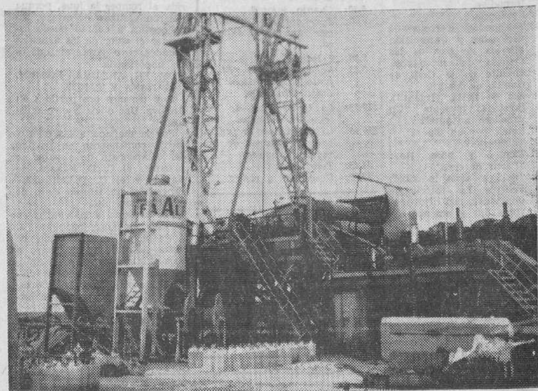
He aquí un primer plano del complejo técnico que sirve para los trabajos de perforación en Hontomín, cuya zona se señala como el probable segundo campo petrolífero burgalés. (Foto Fede)
