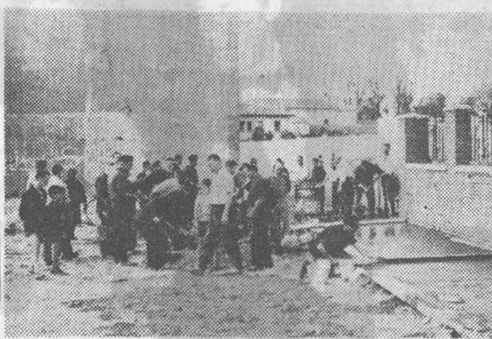
Feligreses de la nueva parroquia durante el trabajo de construcción de aceras para facilitar el acceso al templo. (Foto "Fede")
