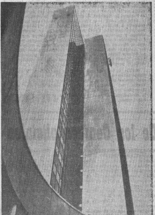
En Düsseldorf (Alemania) se levanta la impresionante estructura, de noventa y cinco metros de altura de la casa de Thyssen. Sus veinticuatro pisos están contruidos de acero, aluminio y cristal. El acero reviste los costados del edificio y tubos, de acero también, han sido empleados como pilares. Con estas edificaciones los urbanistas alemanes ven una posibilidad de edificar en las grandes ciudades, ante la escasez de terreno. — (Foto Fiel)
