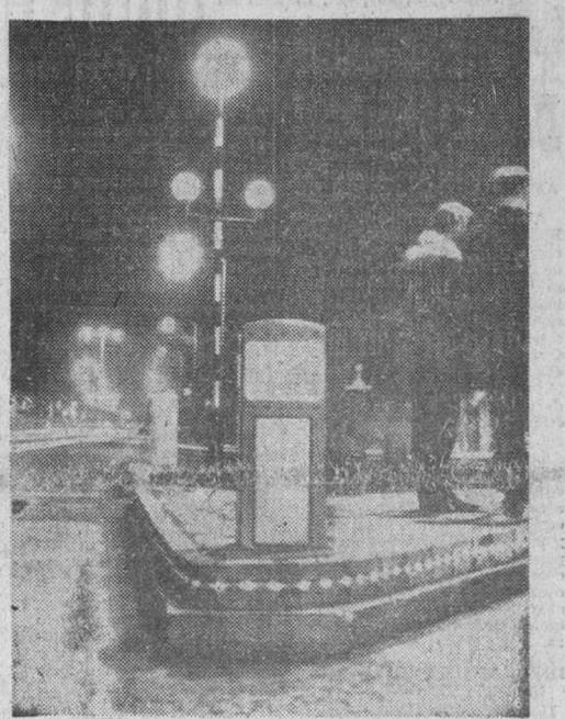
El cruce de carreteras de Clapham Common North y Elspeth Road, al suroeste de Londres, con el nuevo sistema de iluminación instalado en los bordillos contra la niebla. El invento, llamado «Lumistrip» consta de luces amarillas que destellan hasta una distancia de unos 500 metros, instaladas en las piezas especiales de cemento montadas en los bordillos de aceras urbanas y de carreteras.—(Foto Fiel)
