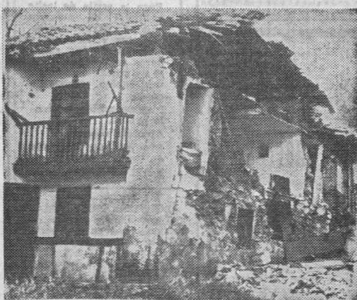
Torrelavega. — Aspecto de los destrozos causados en una de las viviendas cercanas a la mina de bienda de Retón por el hundimiento del techo de dicha mina. Unas cien casas resultaron dañadas y se han producido agrietamientos en la carretera y en terrenos cercanos a la mina. — (Cifra Gráfica)
