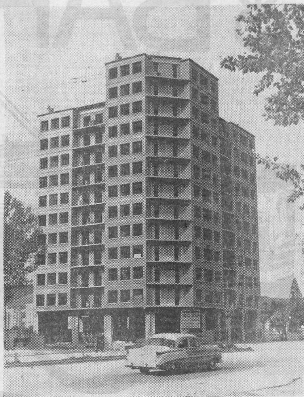
Estado actual de las obras para el primer edificio del gran polígono residencial que la Caja de Ahorros del Círculo Católico proyecta en la zona comprendida entre las avenidas de los Reyes Católicos, Cid Campeador y General Vigón. Sobre este magno plan urbanístico ya hemos informado en otras ocasiones. Su realización marchará al ritmo que permitan las circunstancias, siendo propósito de nuestra más veterana Entidad Benéfica de Ahorro llevarlo a cabo lo más pronto posible, pues en la actividad constructora centra una de sus mayores atenciones, dada la coyuntura e veloz expansión que Burgos vive. Las últimas adjudicaciones de protección oficial que el Ministerio de la Vivienda ha hecho a las cuatro constructoras del Círculo y su Caja suman en total 502 viviendas. La "foto" corresponde al bloque residencial que hace chaffán entre las avenidas de los Reyes Católicos y General Vigón.
