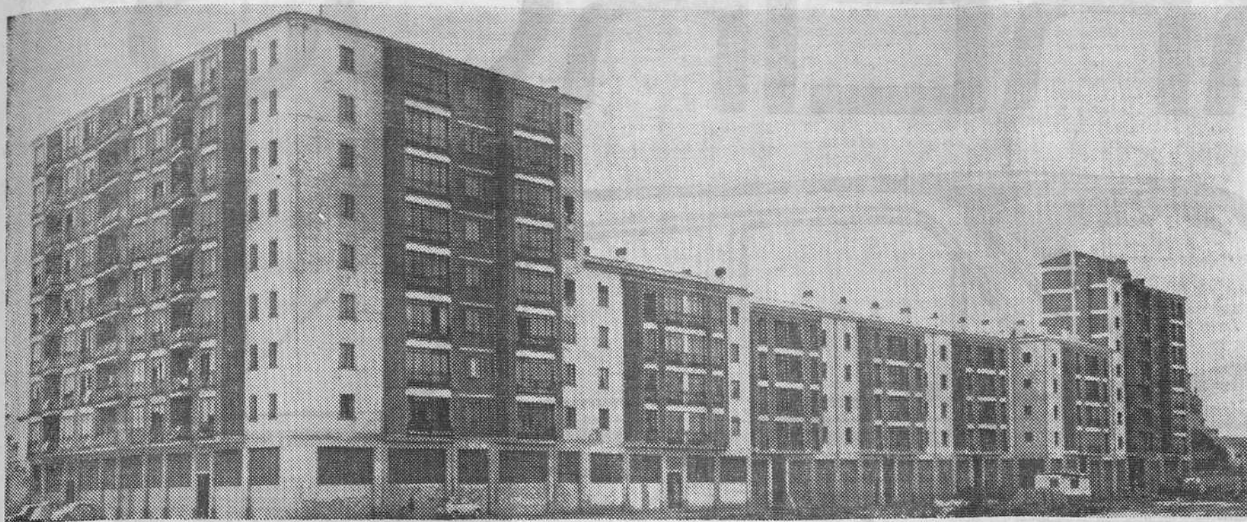
Grupo de viviendas que las Constructoras Benéficas del Círculo Católico de Obreros han levantado en la zona del Morco y que, en trance de próxima construcción, casi perfila una nueva manzana emplazada en sector del máximo porvenir urbanístico.
