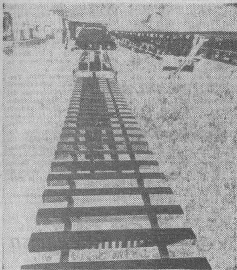
En la República Federal Alemana ha sido puesta en servicio esta moderna grúa para la colocación de ferrocarriles. El vehículo se desliza sobre ruedas y puede colocar en una hora rieles y traviesas prefabricados de 15 metros de largo en un tramo de 200 metros. Aquí la vemos durante una demostración efectuada en Múnich. — (Foto Fiel)
