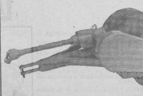
Efecto de compresión hasta 25 to. con un peso propio de 1,7 ton.
