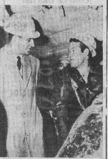
Madrid.— Un momento de la visita realizada por el Príncipe D. Juan Carlos de Borbón a las obras de construcción de infraestructuras de las líneas Caliao-Fuente de Toledo y Puente de Toledo-Carabanchel, del ferrocarril Metropolitano de Madrid. (Foto CIFRA)
