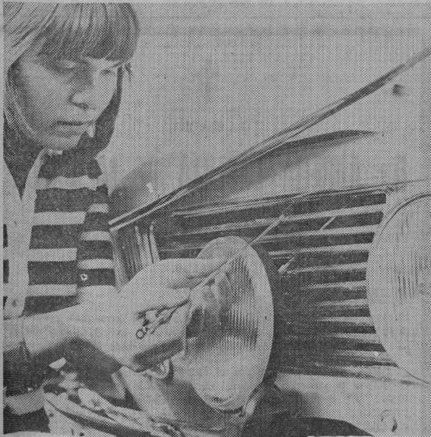
Stuttgart. Para evitar las vibraciones de los faros de niebla y larga distancia, la Robert Bosch GmbH, en Stuttgart (República Federal de Alemania), ofrece una barra estática graduada. Gracias a este apoyo complementario de los faros contra la carrocería, se neutralizan las vibraciones que se pueden presentar, especialmente en el montaje de grandes y potentes faros en los parachoques o en piezas de la carrocería. — (Foto Did-Boch).
