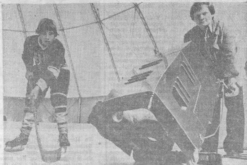
En Alemania acaba de presentarse la pista de hielo hecha de material plástico ultramolecular y de baja presión, tan resistente al desgaste como el acero. Esta pista de patinaje, económica en su construcción y en su mantenimiento, se limpia fácilmente con un aspirador especial — está pensada sobre todo para fomentar la práctica del hockey sobre hielo. — (Foto FIEL-INTERNATIONS)
