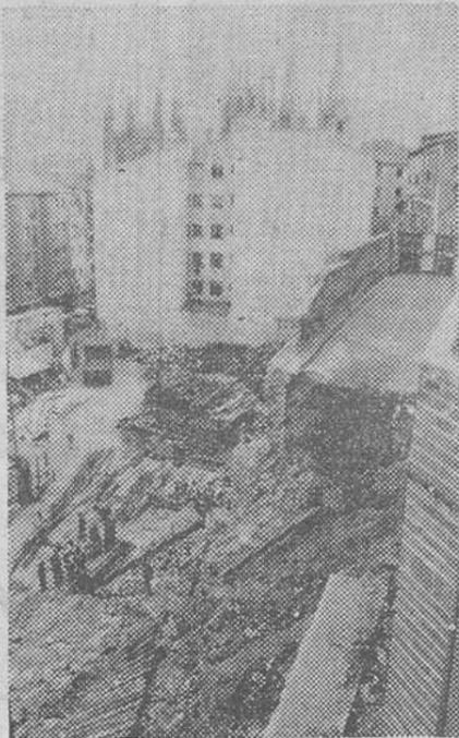
En estas dos fotografías de FEDE puede apreciarse la parte de la calle Hospital de los Ciegos afectada por el hundimiento, precisamente frente a la entrada del colegio Saldaña, en su parte antigua. Se ve también cómo unos obreros están procediendo a reforzar el muro de contención derrumbado mediante vigas de hierro.
