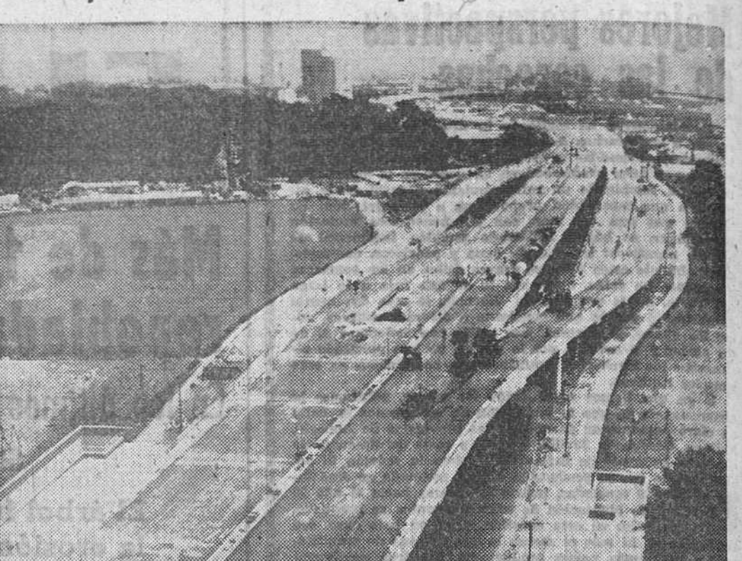
Está próximo a ser concluido el tramo Chiewick-Langley de la nueva autopista de Gales del Sur, en las proximidades de Londres. En la fotografía vemos el lugar donde se superpone la nueva autopista elevada por encima de la gran carretera del Oeste. — (Foto Fiel)
