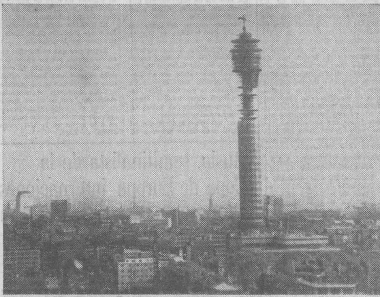
Sobresaliendo entre todos los edificios de Londres vemos a la nueva torre de Correos que mide unos 174 metros de altura. En ella están instalados los servicios para la recepción y transmisión de enlaces con microondas para la televisión y el servicio telefónico. Está recubierta totalmente de cristal y en su parte superior, cuando esté terminada, se montará un restaurante giratorio que dará una vuelta completa cada media hora.—(Foto Fiel).
