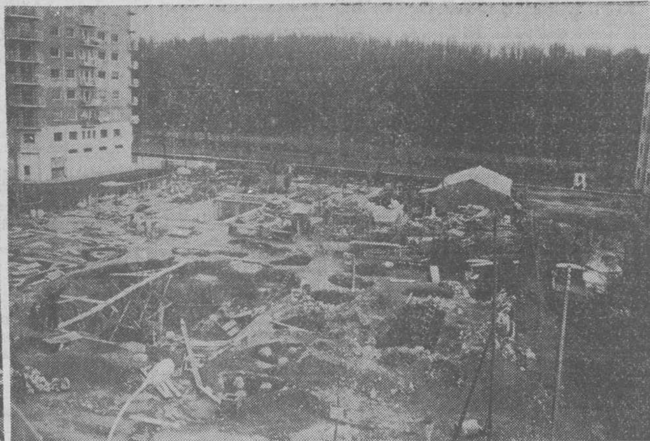
ASI VAN LOS TRABAJOS EN EL GRUPO RESIDENCIAL DE VITORIA. NUMERO 56.
