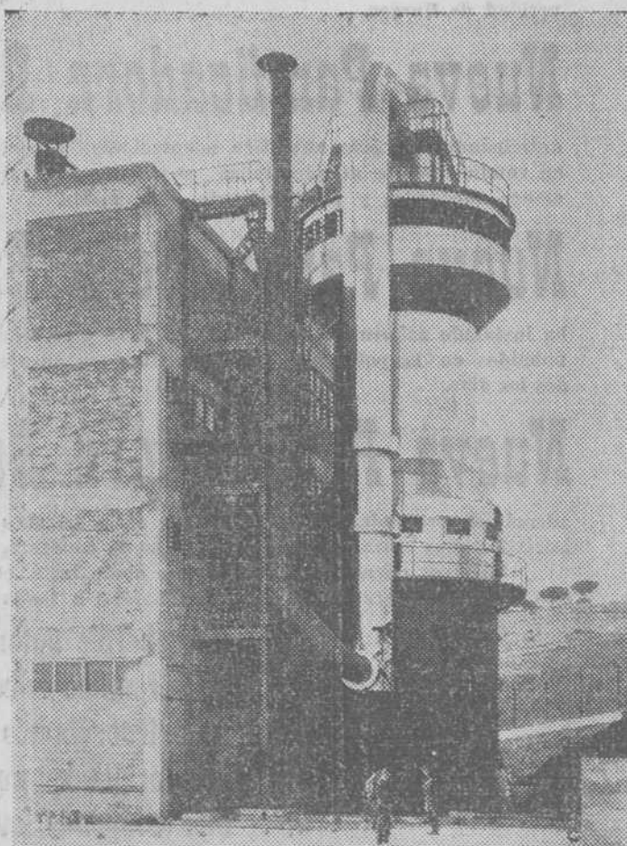
Vista de una de las grandes torres atomizadoras de la nueva fábrica de Henkel Ibérica en Montornès del Vallès. Las tres figuras humanas próximas a la base de la torre permiten hacerse una idea de las proporciones de la misma.
