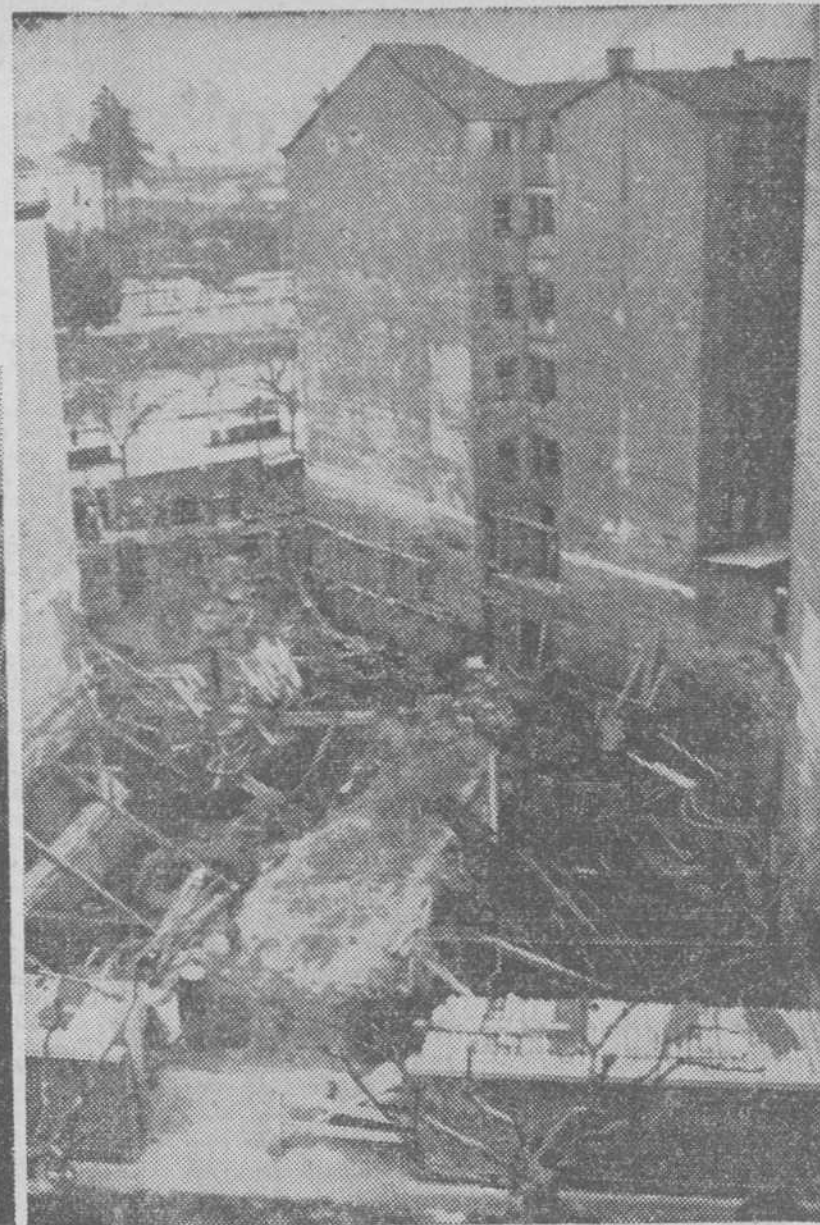
ESTADO DE LAS OBRAS EN AVENIDA GENERALISIMO 8
