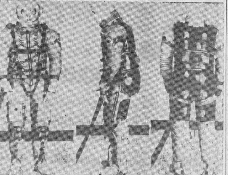
Ante la inminencia del primer lanzamiento de una cápsula espacial «Apolo», he aquí el nuevo traje que vestirán los astronautas. Pertenece al estilo «Homards» y está fabricado con aluminio, reforzado con fibra de vidrio. Protegerá especialmente a los astronautas en el lanzamiento y regreso. (Foto FIEL)
