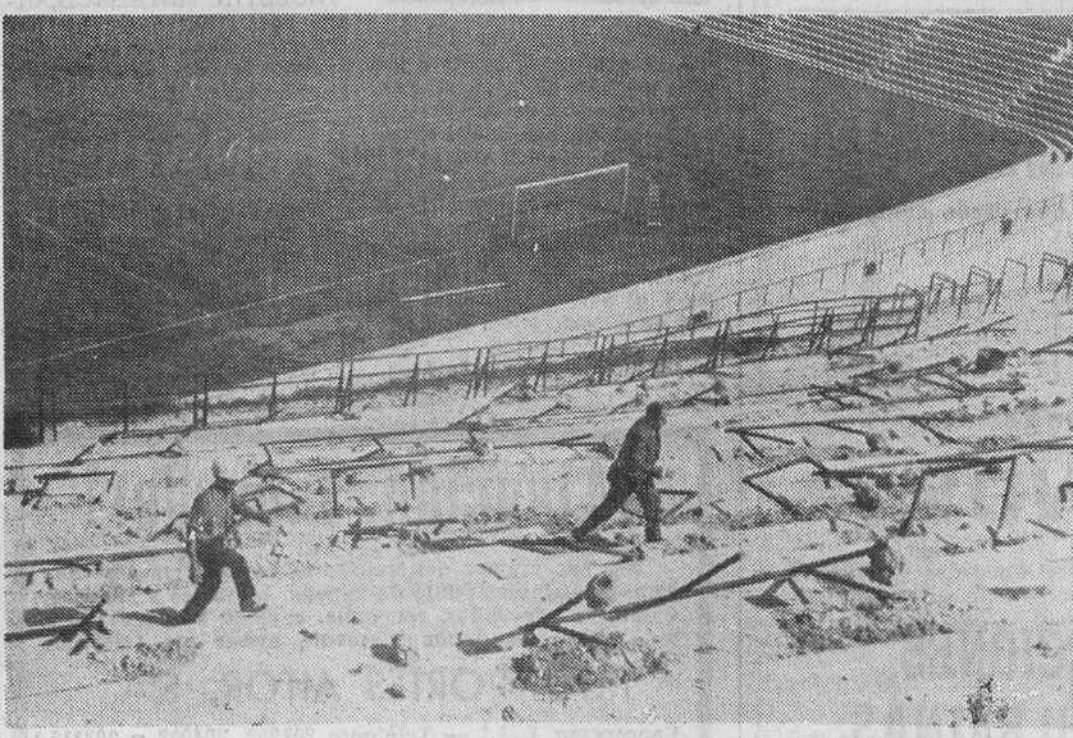
Madrid. — Primeros trabajos del derribo del Estadio Metropolitano por obreros al servicio de sus actuales propietarios, la Inmobiliaria Vistahermosa. Mientras el nuevo Estadio del Manzanares no se halle en condiciones, los jugadores del Atlético de Madrid se entrenarán en el campo de deportes del Parque Sindical. — (Foto Cifra Gráfica).
