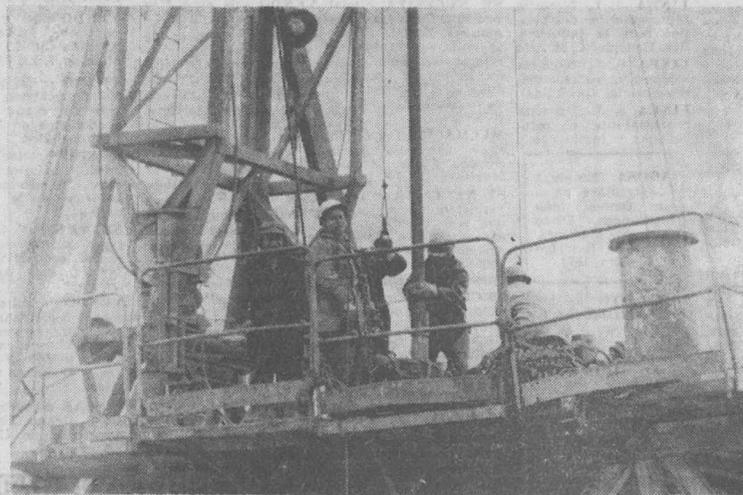
Como a un extraño visitante, dos perforadores del «Escalada 1» miran hacia el objetivo de «Fedé», mientras otros operarios se aplican a la tarea de introducir un nuevo tubo de perforación en la cabeza de pozo.
