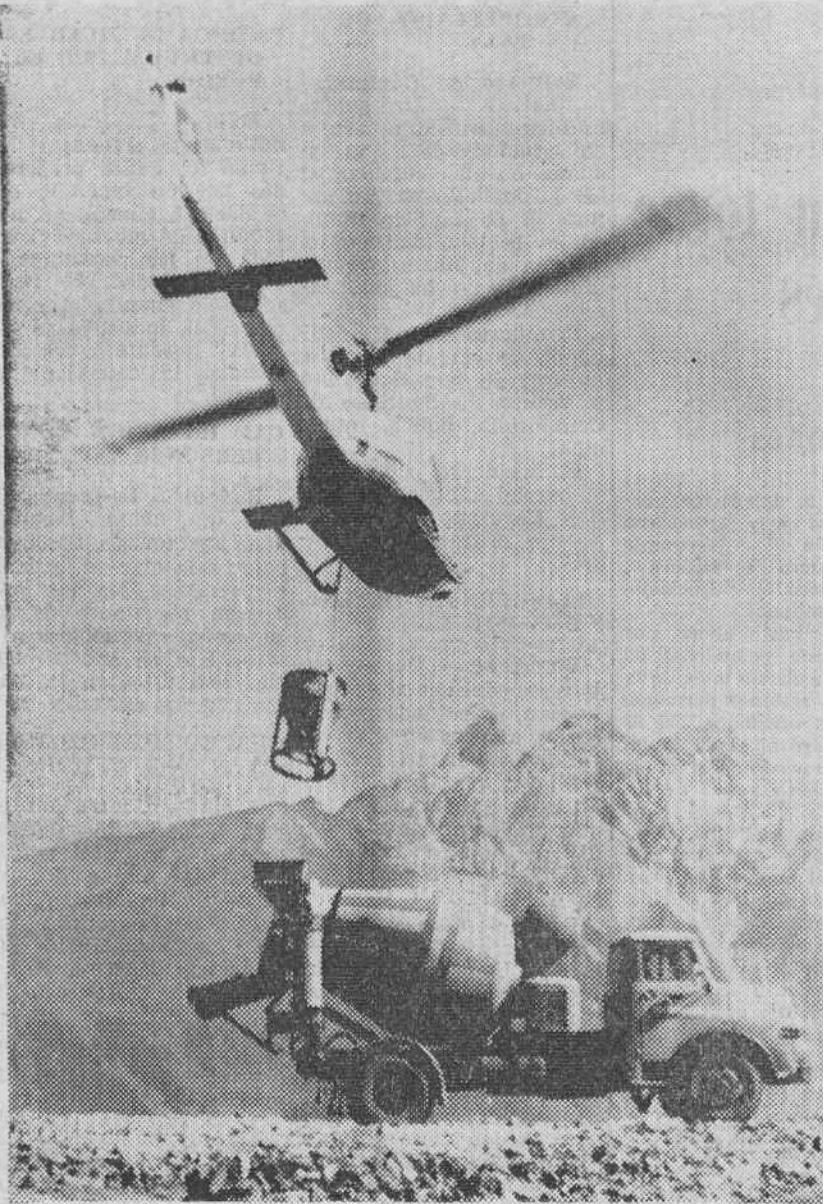
Oberstdorfer (Alemania). — Ante lo inaccesible del terreno a los vehículos, un helicóptero es utilizado para el transporte de materiales utilizados en la construcción de una telecabina en la cumbre de Fellhorn, cerca de esta localidad. — (Telefoto CIFRA GRAFICA)
