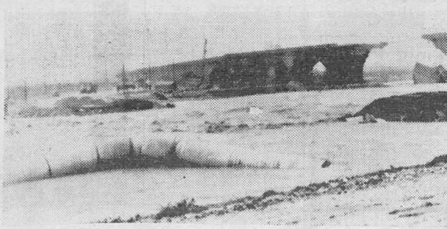
Molins de Rey (Barcelona). — Las aguas del río Llobregat han destruido el badén provisional construido sobre el río, debido a la fuerte lluvia caída durante la noche del pasado jueves. — (Telefoto Cifra Gráfica).
