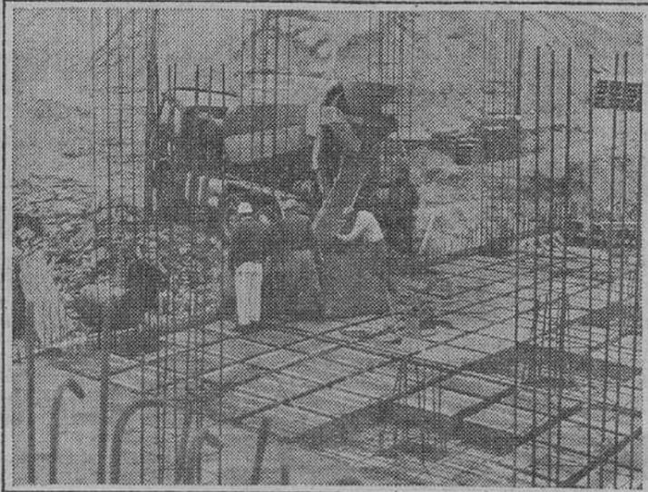
Hacen falta 200.000 m<sup>3</sup> de hormigón para construir unos edificios. Los camiones-hormigonera Pegaso 3.060 GL, de 200 cv., los llevan. La gran solidez de su bastidor, así como la de su eje delantero, el puente posterior, previsto de un sistema de bloqueo a voluntad, mediante un tercer diferencial, permiten a este Pegaso actuar en terrenos difíciles.
