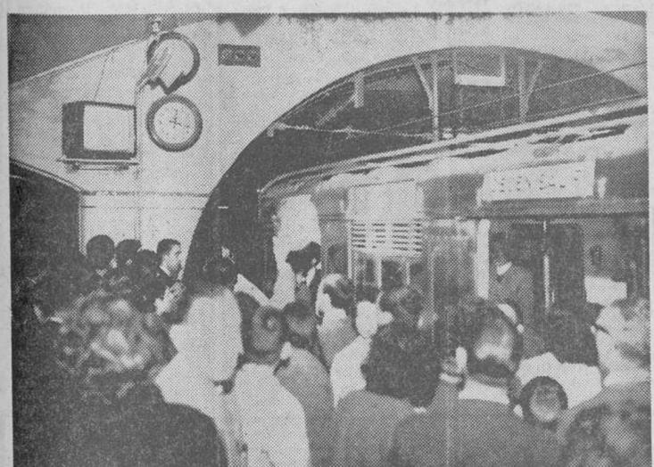
Instantánea de una estación madrileña en pleno tráfico. Puede apreciarse el aparato de televisión que, conectado a un circuito, permite un mejor control de maniobra. — (Foto CIFRA)
